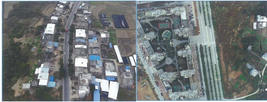
桥头铺段 江华县城段 图 3.2-1 本工程拟改造利用现有道路现状照片
