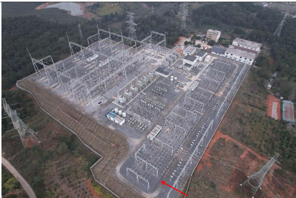
紫霞 500kV 变电站现状
